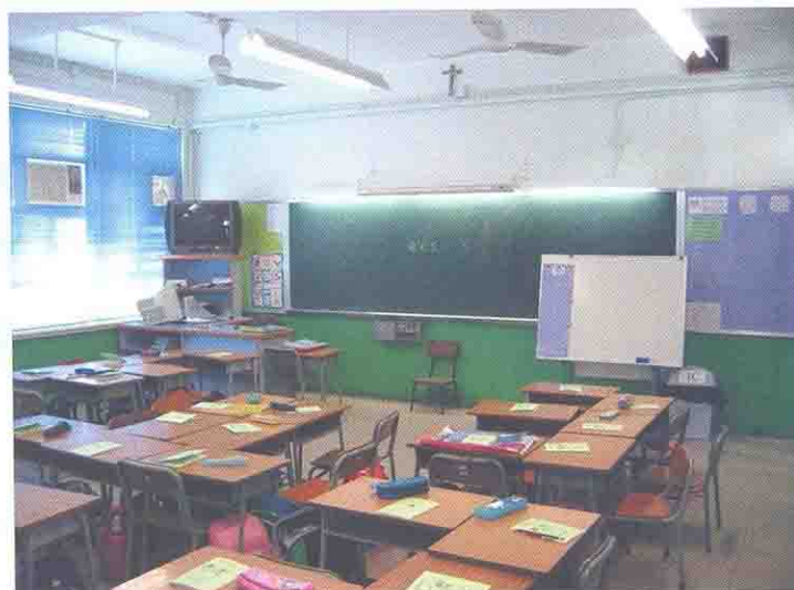
改善工程後的二樓課室外貌
