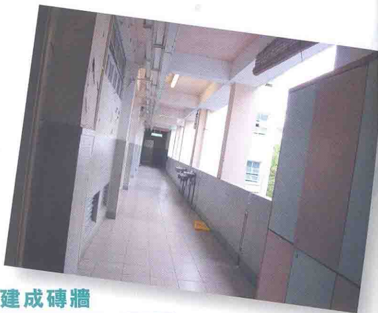
重鋪後的走廊外貌
