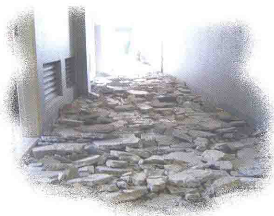
學校走廊重鋪前外貌
