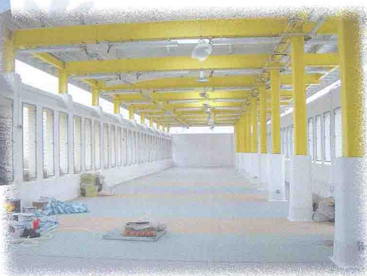
本校天台工程已接近完成階段
